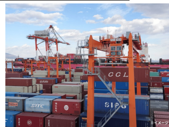
KICT ガントリークレーン
