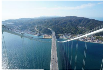
明石海峡大橋
